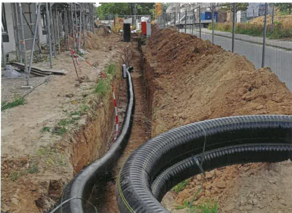
Lange Lebensdauer: Der Einsatz von vorisolierten Kunststoffleitungen im Rohr- und Tiefbau bringt Kostenvorteile.
