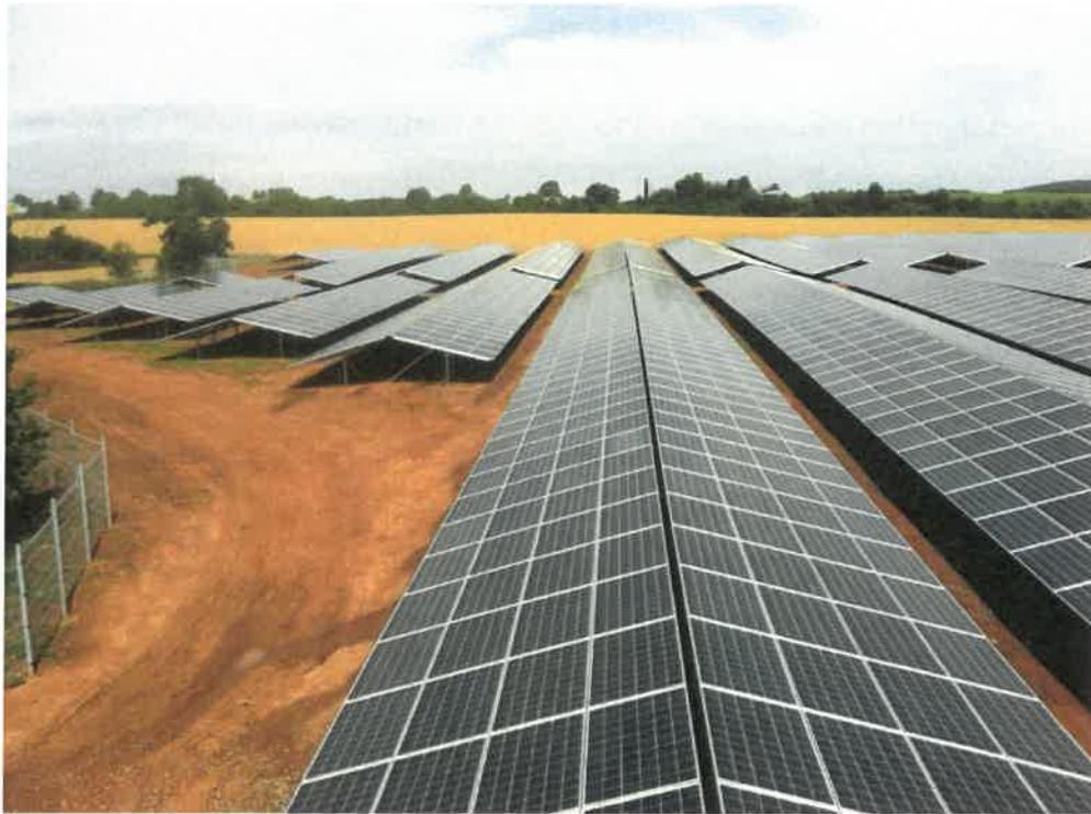
Abbildung 9: Freiflächen-PV Ost/West-Aufständerung 4 Module
