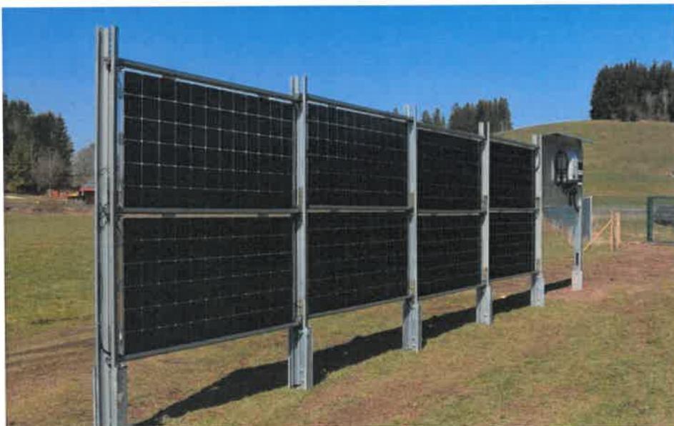
Abbildung 11: Vertikale Photovoltaikanlagen
