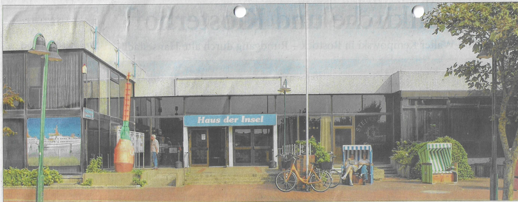
Das Haus der Insel auf Langeoog ist alt und marode. Was an seine Stelle treten soll, daran scheiden sich noch die Geister.
